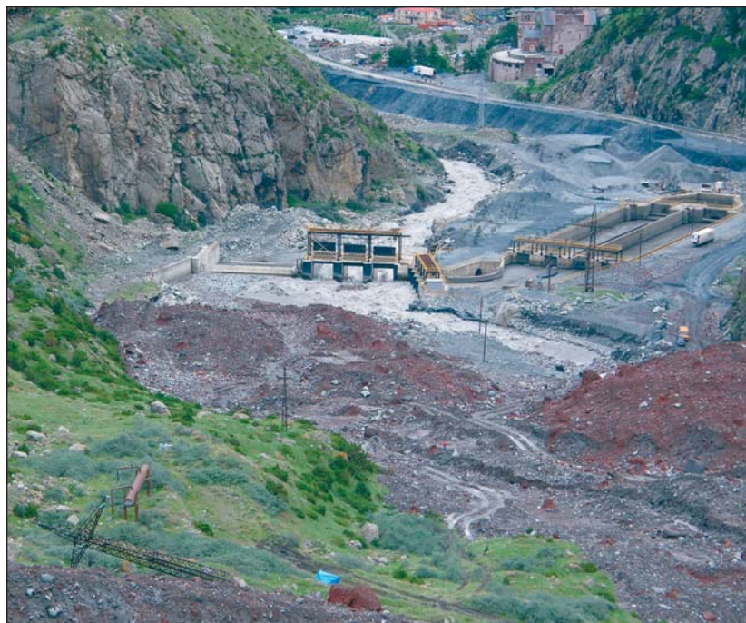
Поток остановился в нескольких десятках метров от шлюза и бассейна-отстойника строящейся Дарьяльской ГЭС. 20 мая 2014 г.
