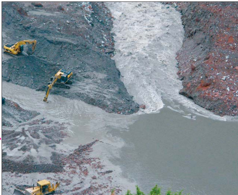
Работы по созданию нового русла Терека. Вечер 19 мая.
